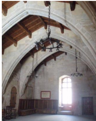
Paraments interior sud i oest
