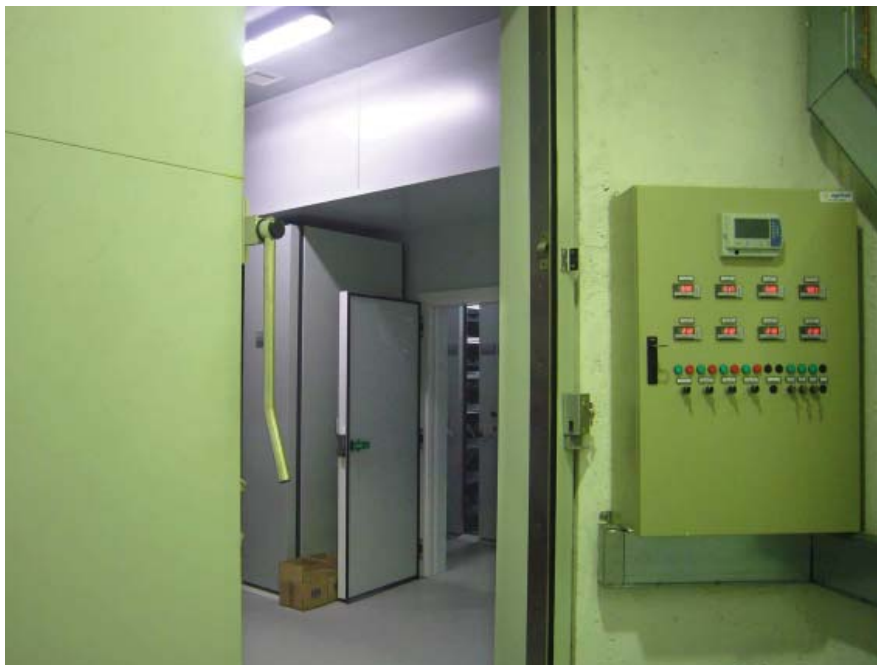
Càmeres per al control de la temperatura i la humitat relativa dins de l'arxiu fotogràfic i audiovisual. Museu d'Art Contemporani de Barcelona. Fotografia: cortesia del Museu d'Art Contemporani de Barcelona (MACBA).
