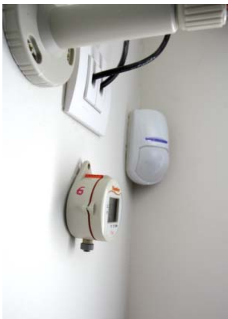
Col·locació d'aparells de mesura de dades climàtiques durant el muntatge de les sales d'exposició permanent del Museu de Maricel (Sitges, 2014).
