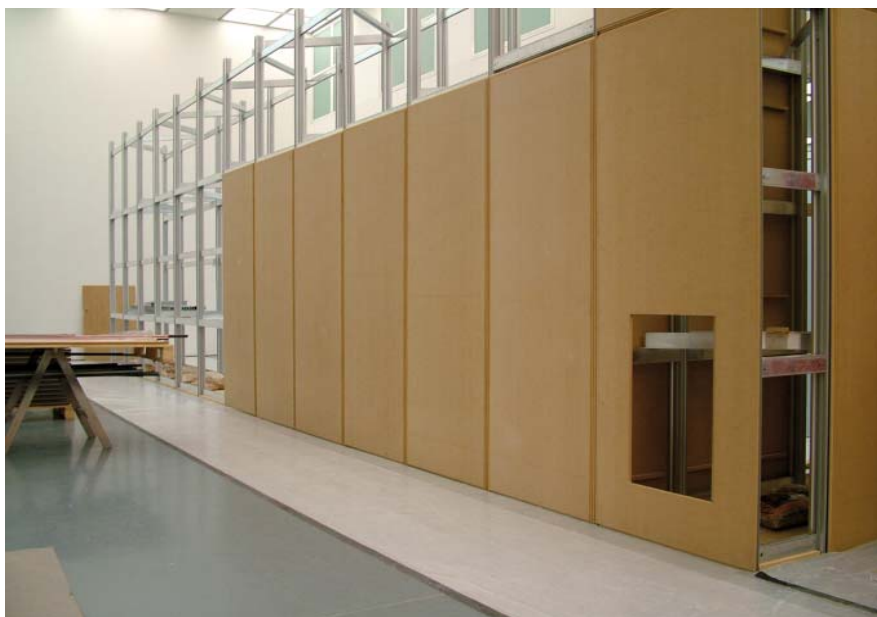
Instal·lació del sistema modular de parets. Museum Kunstpalast (Düsseldorf). Fotografia: cortesia de Reform System, LTD.
